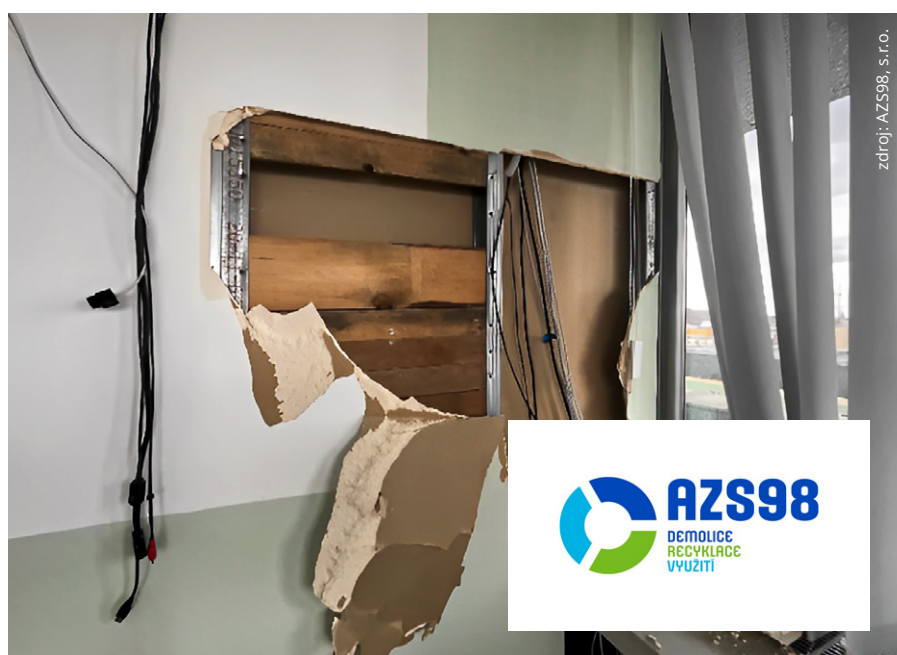
Ukázka provádění sond ve stavební konstrukci
