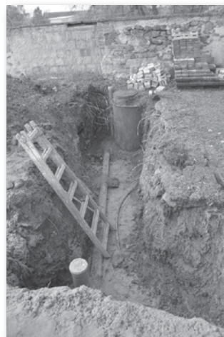
Napojení vody a kanalizace
